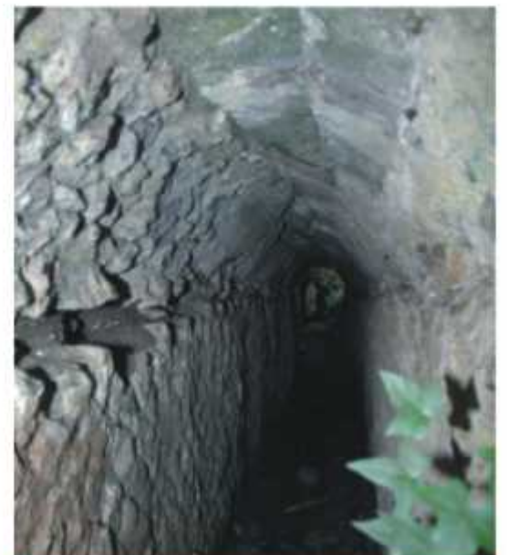
INTERNO DELL'ACQUEDOTTO DI MALAFFITTO
